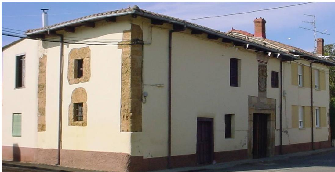
La vivienda es de dos plantas, con cubierta a 3 aguas de entramado de madera y teja cerámica curva. El revocado más reciente ha cubierto la fábrica original, dejando visibles únicamente los recercados de los huecos principales, realizados con sillares de piedra.
