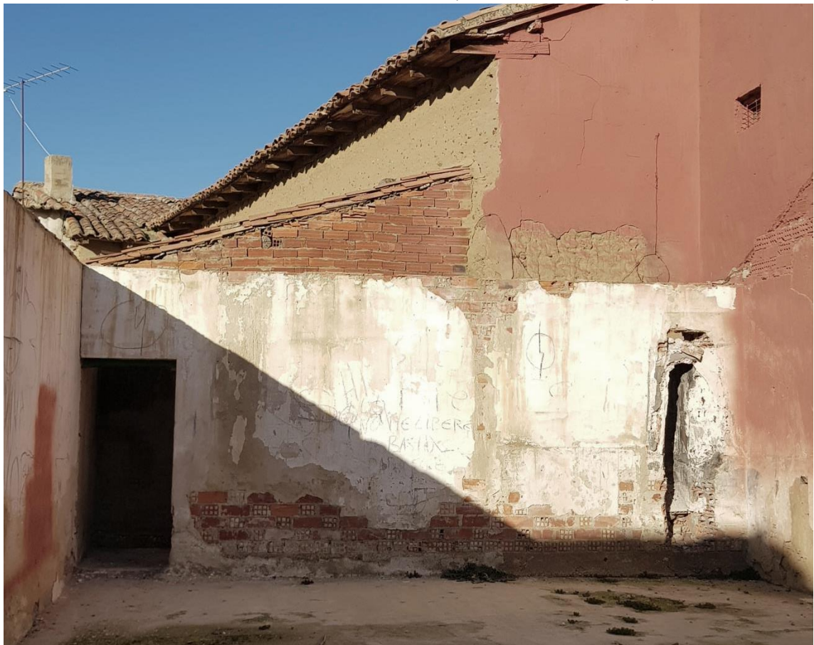
Vista del interior de los restos del cerramiento y solado existentes en la parcela.
