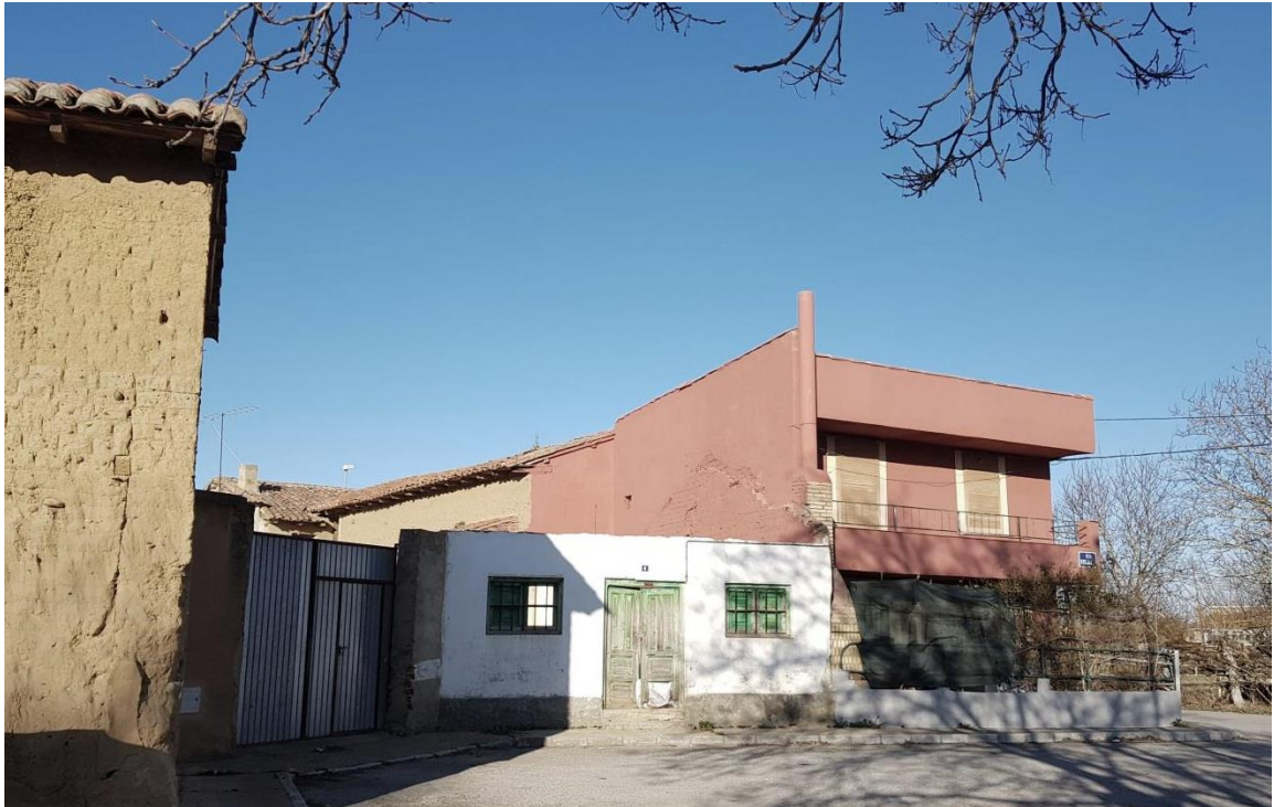
Vista del estado actual de la parcela (en el centro de la imagen) desde C/ Solana, 4.
